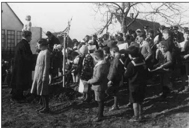
V létě 1922 uschla Lípa svobody, která byla zasazena v rohu školní zahrady. Dne 26. března 1933 se konala ve škole a okolí veřejná oslava prvního roku školství a národní osvěty. Na počest prvního ministra školství Gustava Habrmána byla správnou školou vysazena u pomníku padlých "Lípa Habrmanova".
