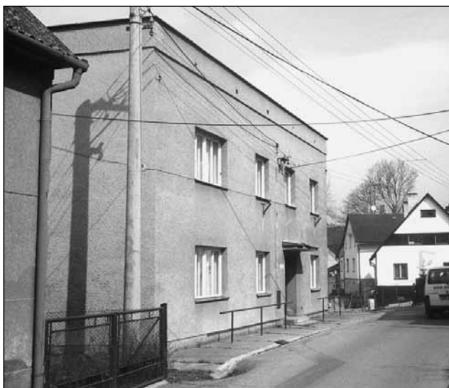
Přebudovaná stará škola, později kulturní dům, dnes zamýšlená turistická ubytovna.
